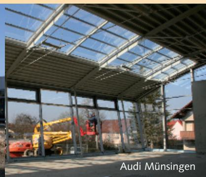
Wir verarbeiten hochwertige, wärmegeämmte, thermisch getrennte Aluminiumprofile. Ansichtsbreite 50 mm.
